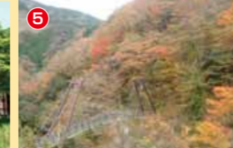
5 せんだん轟吊橋
