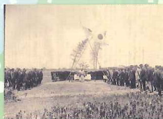
九州製紙株式会社八代工場地鎮祭 大正12年(1923)
