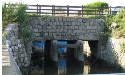
大鞘樋門(二番樋)
