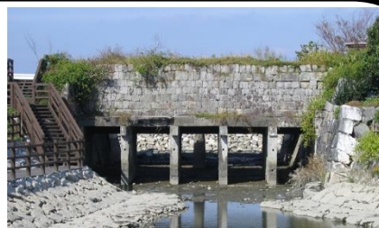
大鞘樋門(殻樋)
